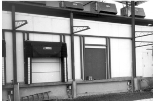
Nestle Panama S.A. (23 x 21 x 7.5 metros) en construcción Freezer de helados a -30°C antecámara para 6 puertas de carga.
