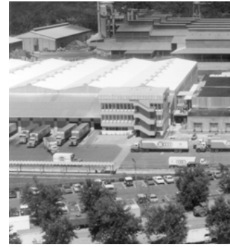
CADA Supermercados Venezuela con estructura interna de acero.
